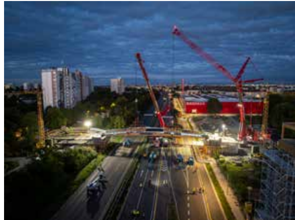
Die neue Brücke überquert die B 38, die während des Einbaus für den Verkehr gesperrt werden musste
