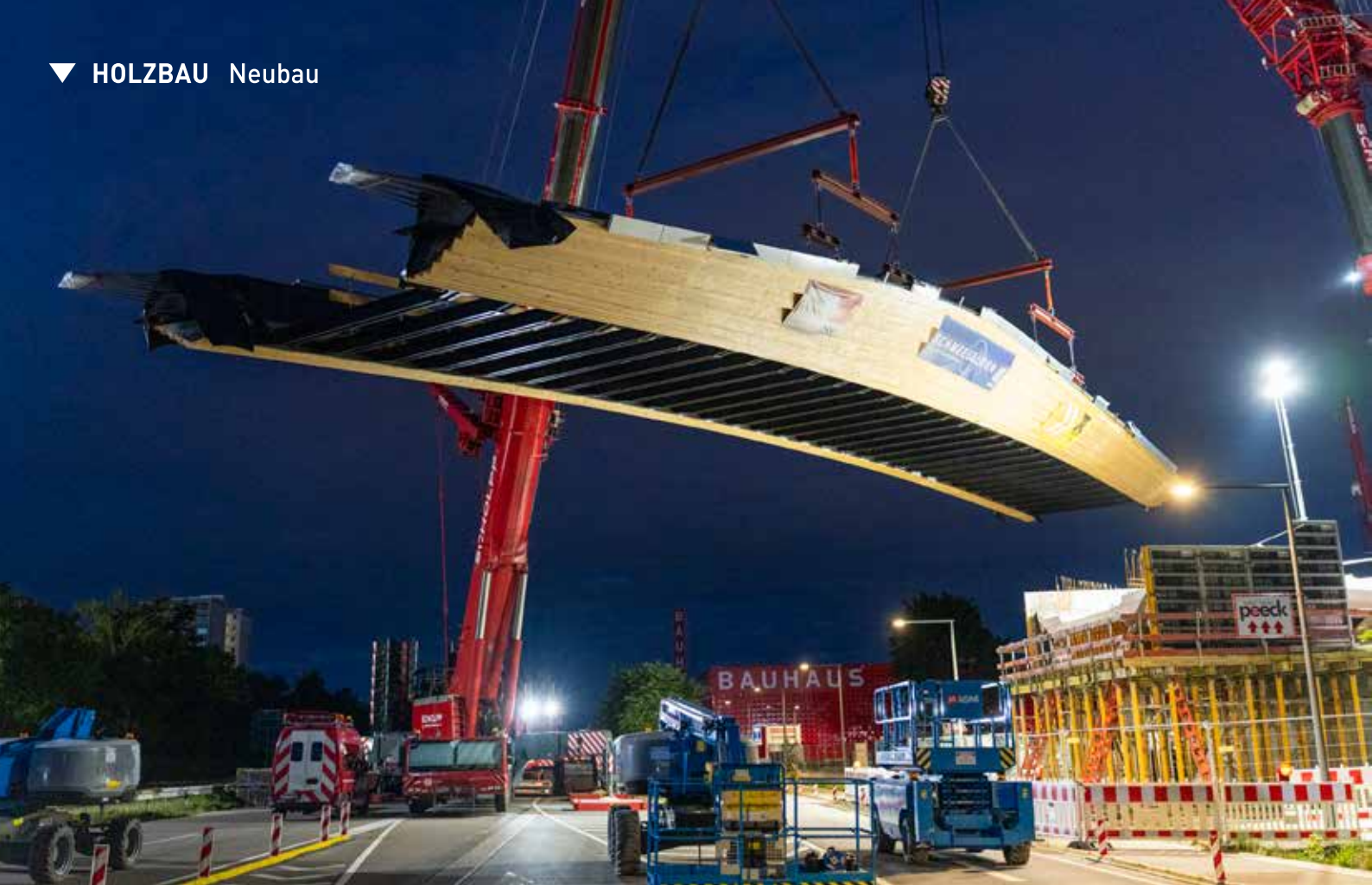
Ende August 2025 wurde die Fußgänger- und Radfahrerbrücke mit einem Einhubgewicht von 104 t eingehoben
